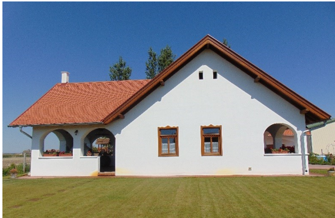
Új építésű nagy alapterületű épület a külterület határán gazdálkodó települékhöz közel, lakhatás, munkahely egy helyen, igényesen kialakított.
